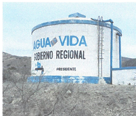
Reservorio R2 apoyado de V=1000 m 3 Distancia Pozo a Reservorio R2 11.1 km
