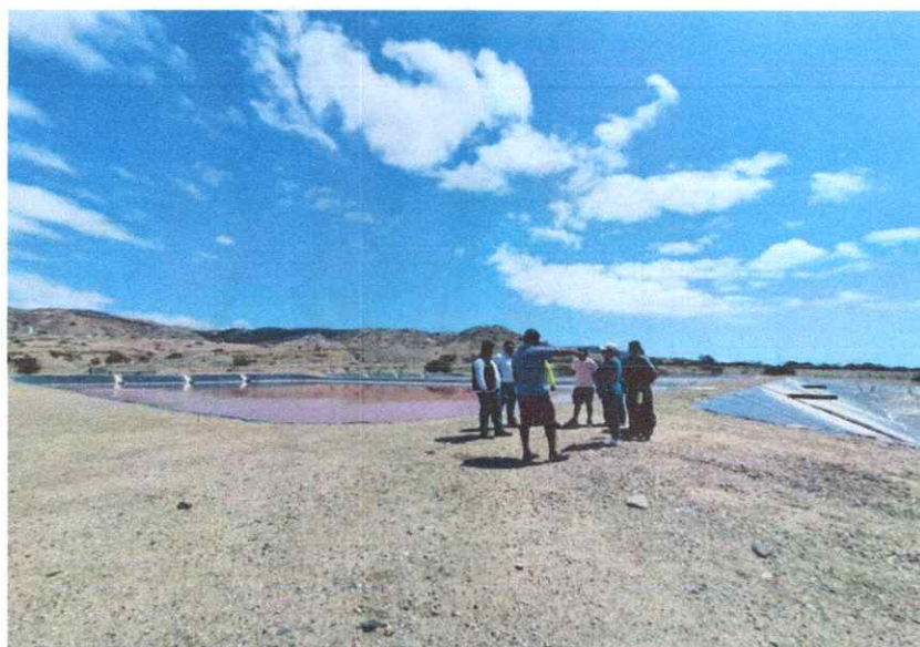
PTAR conformada por dos lagunas primarias y una secundaria
