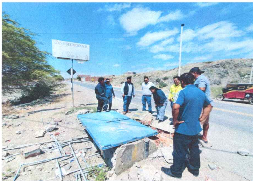
Plataforma de entrega de agua directo de la línea de conducción en plataforma, se aprecia las tuberías de PVC expuestas
