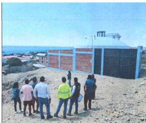
Reservorio apoyado de 250 m3, ubicado en la parte alta del CP Puerto Rico
