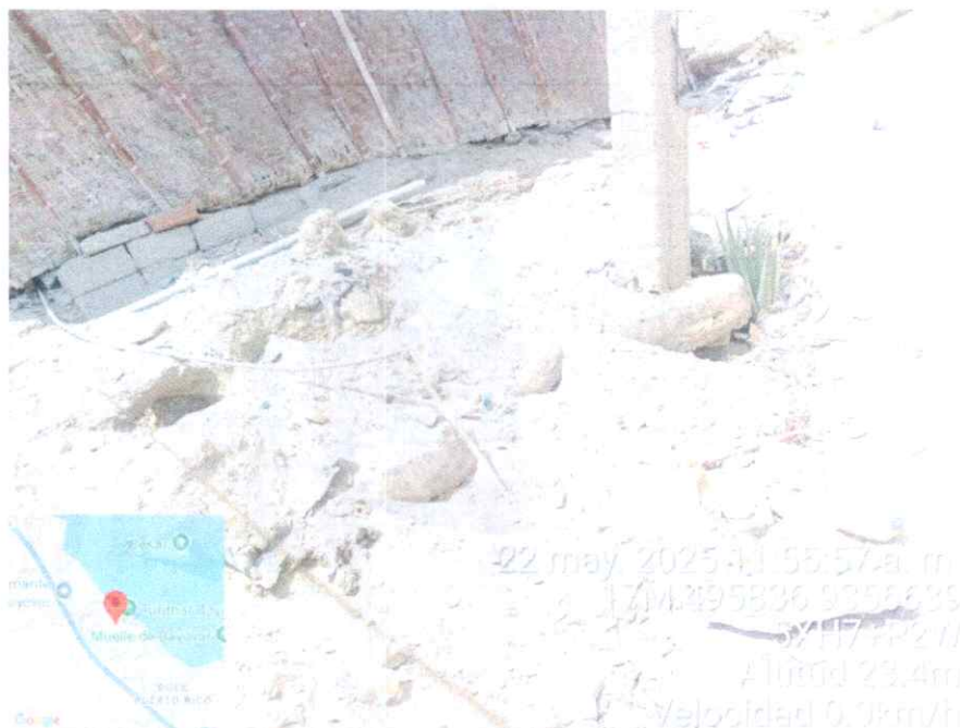
Conexiones domiciliarias de agua en uso, se aprecia las tuberías de PVC expuestas
